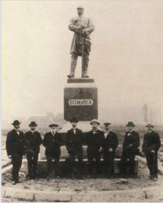
Abb. 5: Der Eickeler Amtmann Karl Berkermann (vierter von rechts) bei der Einweihung des Bismarck-Denkmal, Juni 1904
